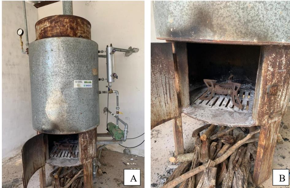
Figura 14 – Caldeira com queimador de biogás (A e B)
