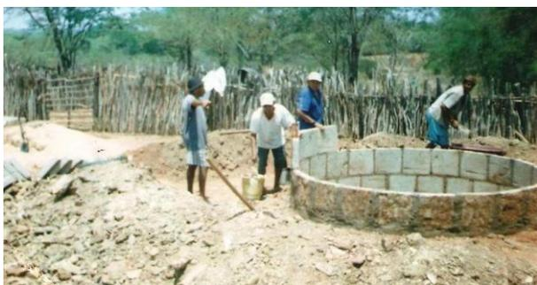
**Figura 13** – Processo de construção das cisternas.
