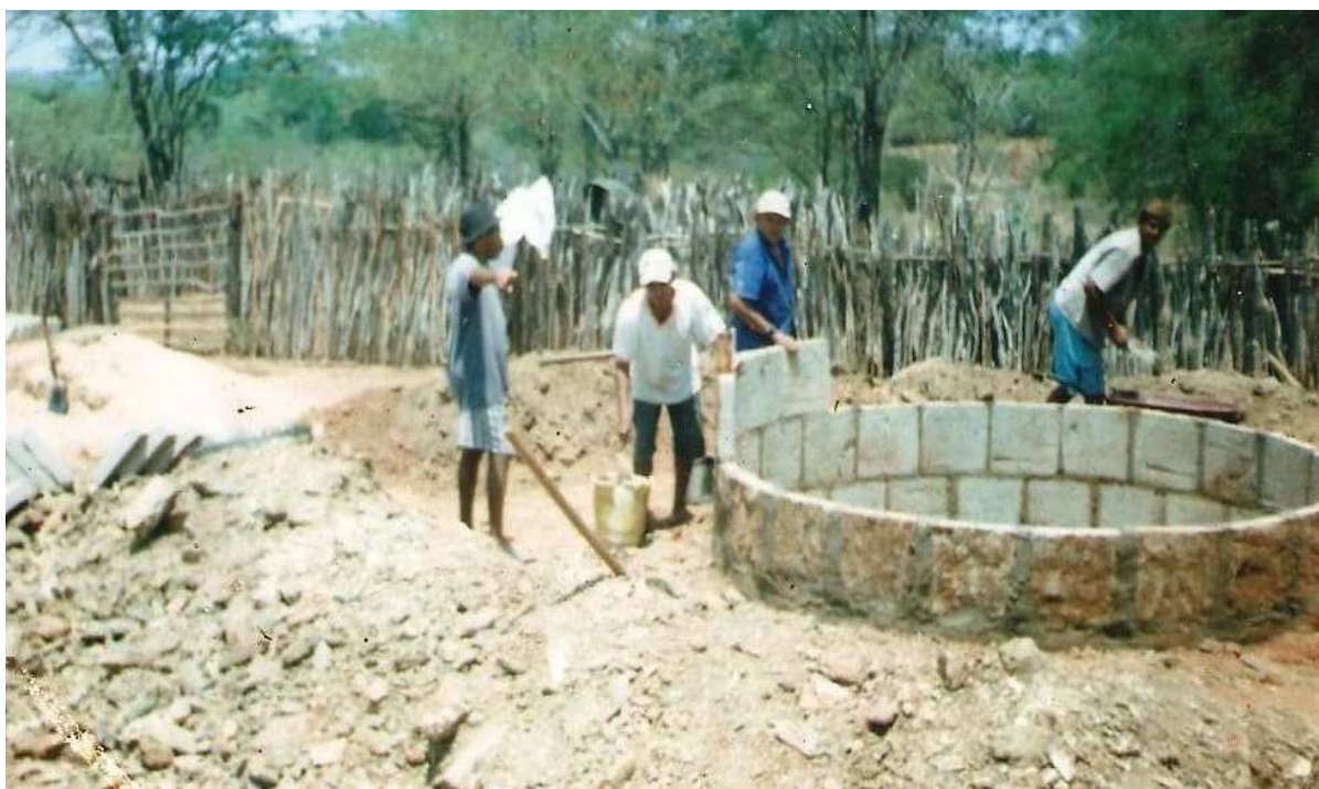
Figura 17 – Processo de construção das cisternas.
