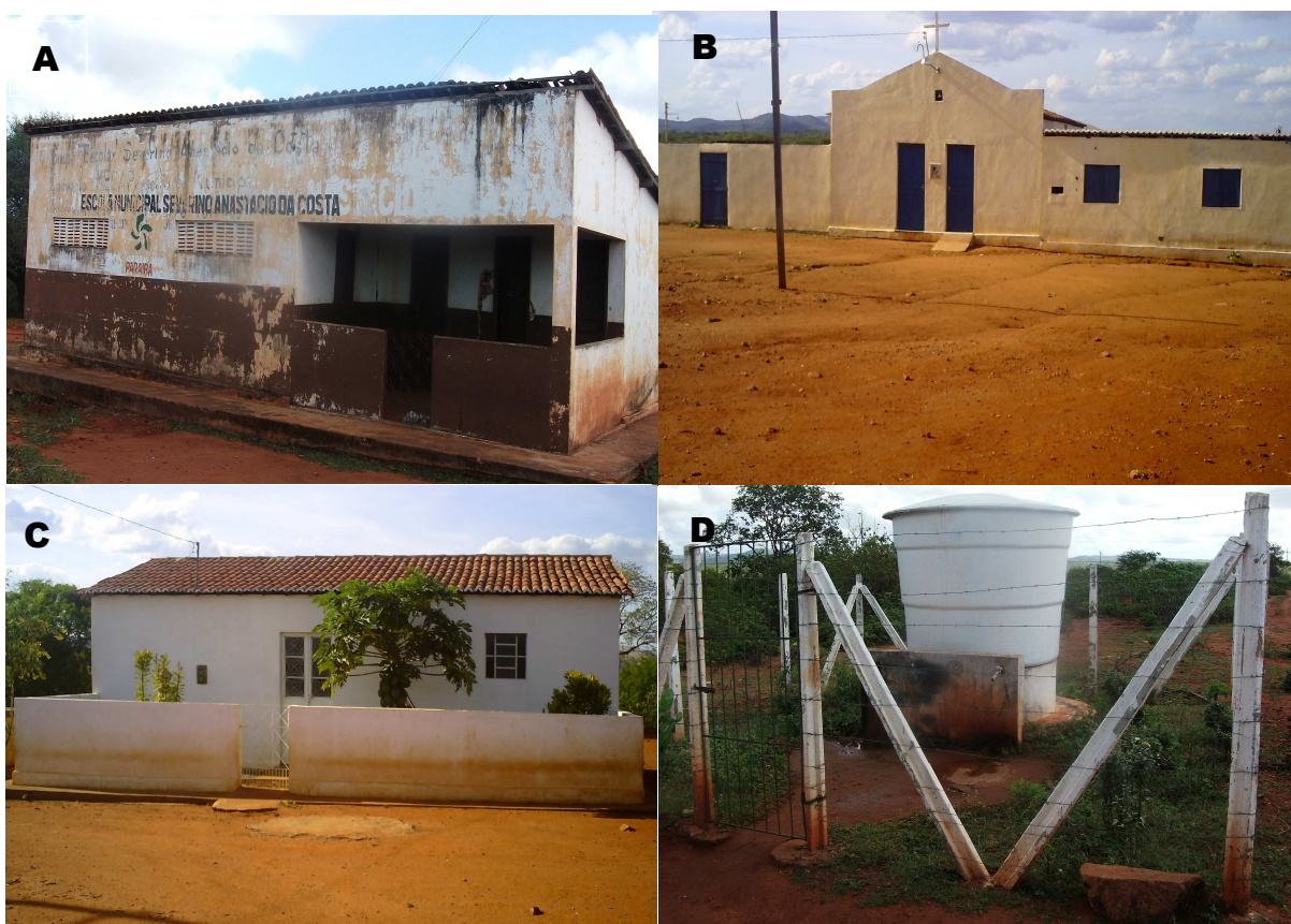
Figura 05 – Estruturas da comunidade. (a): Grupo escolar. (b): Igreja de São João Batista. (c): Posto de saúde. (d): Chafariz.
