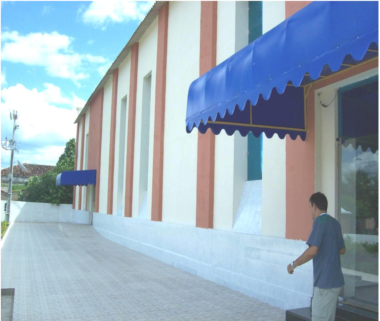
Ilustração 10 - Instalações da futura Faculdade de Flores
