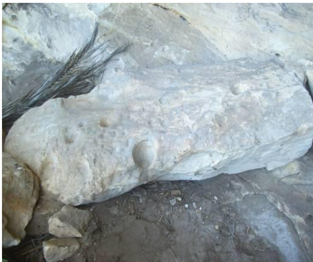
Foto 129 - Bloco de pedra despreendido da rocha suporte
