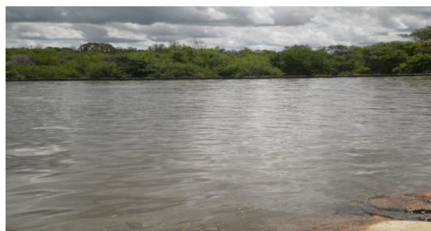
Figura 9 - Barragem construída no riacho. Vegetação nativa após a sua construção
