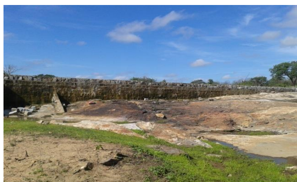
Figura 8 - Construção da barragem no riacho estudado: No solo com rochas afloradas.
