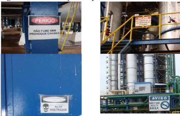
Figura 4 – Identificação das placas de advertência.
