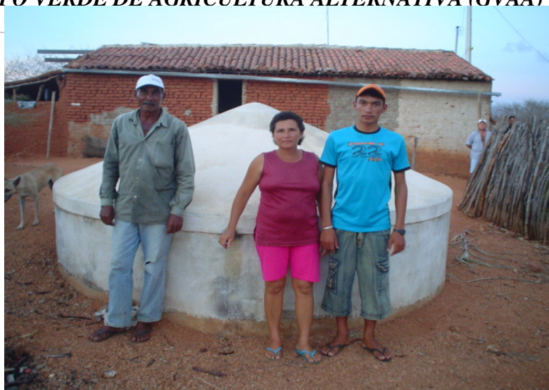
Foto 1 – Cisterna construída na comunidade de Abderramant no município de Caraúbas-RN, usada para captação e armazenamento de água.
