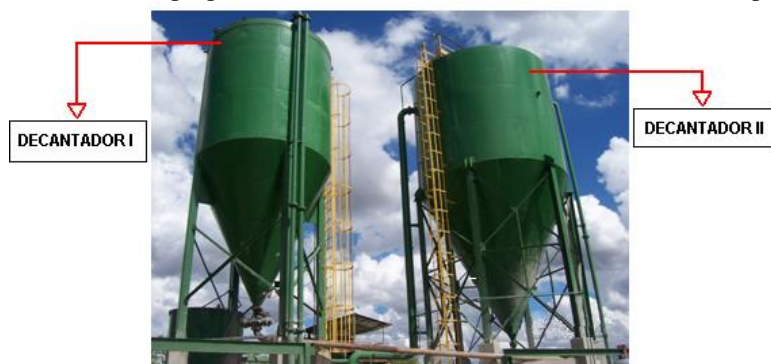
Figura 04: Decantador I (Efluente dos Teares); Decantador II (Efluente da: Politriz automática, Freza, Talha-Bloco, Flameadora e Linha de Ladrilhos). Fonte: Autoria própria, 2009.
