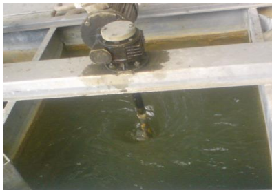
Figura 03: Agitadores do floculador. Fonte: Autoria própria, 2009.
