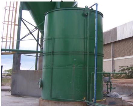
Figura 05: Reservatório de água. Fonte: Autoria própria, 2009.
