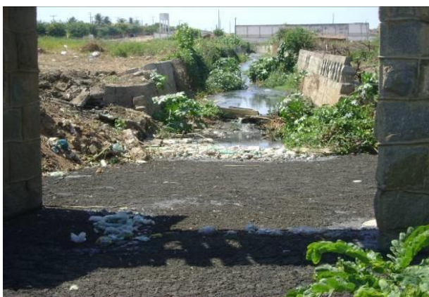
Figura 3: Acumulo de água residuária e resíduos sólidos na ponte do Bairro Janduí Carneiro. Fonte: Arquivo pessoal
