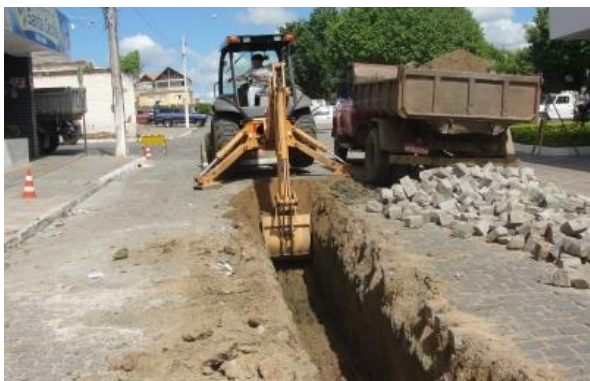
Figura 6: Obra do esgotamento sanitário em Pombal-PB Fonte: www.liberdade96fm.com.br
