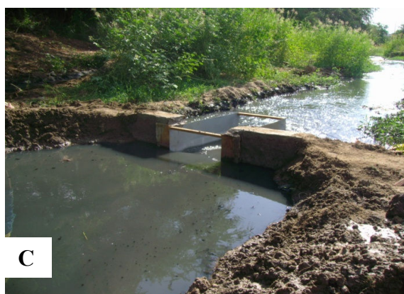
Figura 2. Vertedouro Retangular com Duas Contrações Laterais (A), Medição Com a Régua Graduada (B), e Visão Panorâmica do Vertedouro Instalado (C, D). Pombal, 2008.
