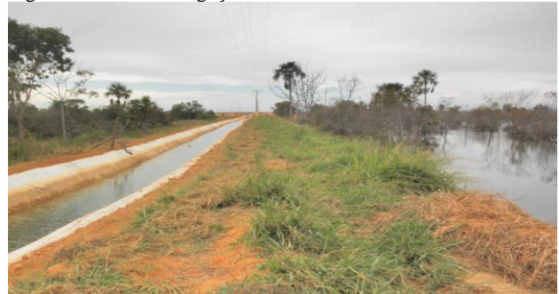
Figura 4. Canal de irrigação construído em área de vereda.
