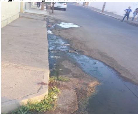
Figura 2: Esgoto a céu aberto.
