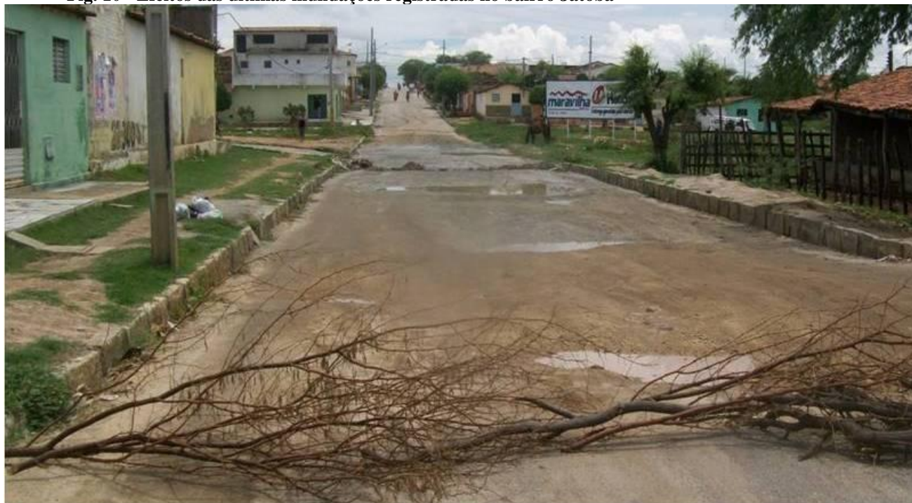
Fig. 10 - Efeitos das últimas inundações registradas no bairro Jatobá
