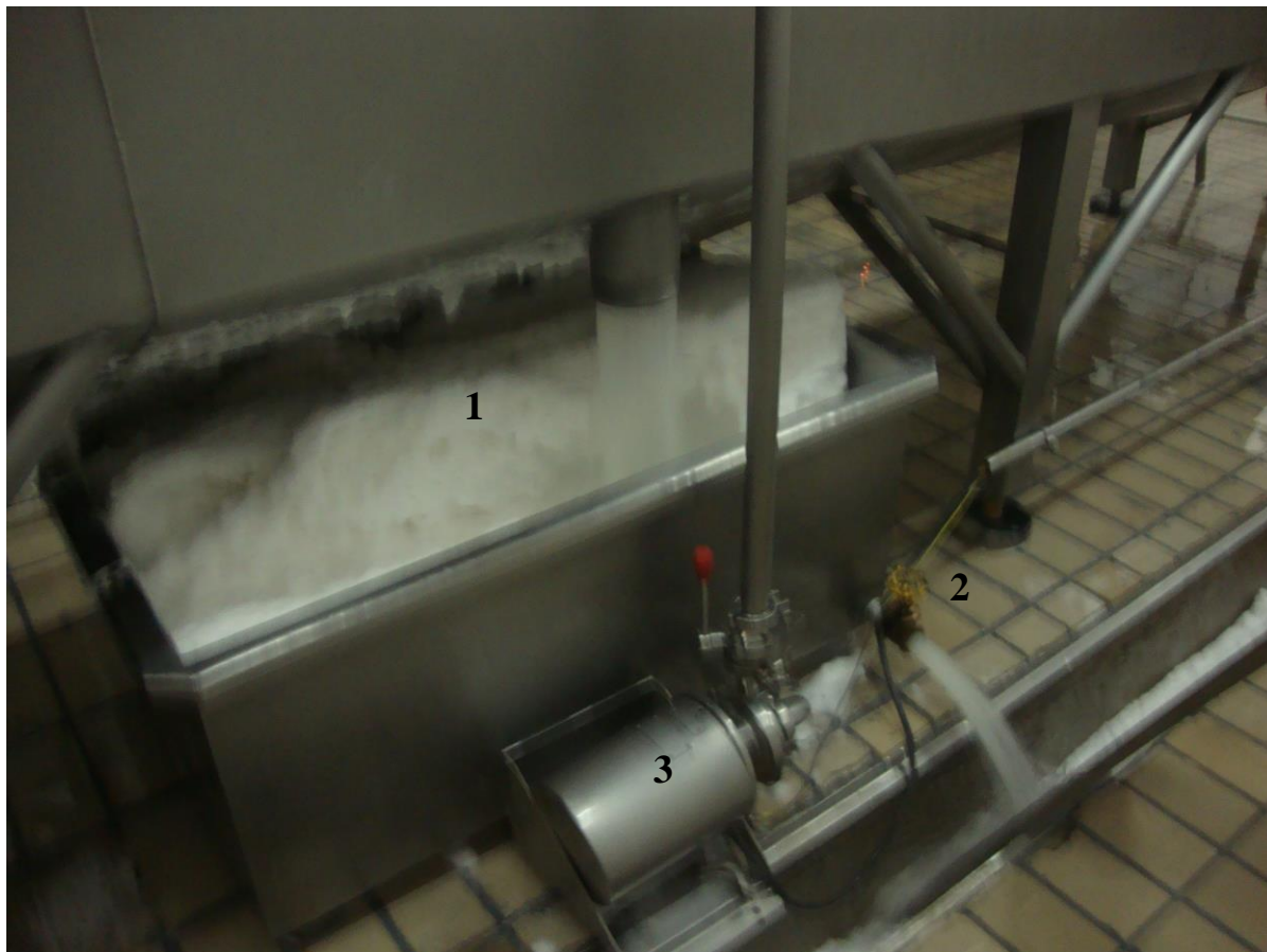
Figura 1. 1 – Água de lavagem de batatas. 2 – Bomba de sucção da água de lavagem. 3 – Válvula para envio da água de lavagem para a Estação de Tratamento de Efluentes (ETE) da indústria
