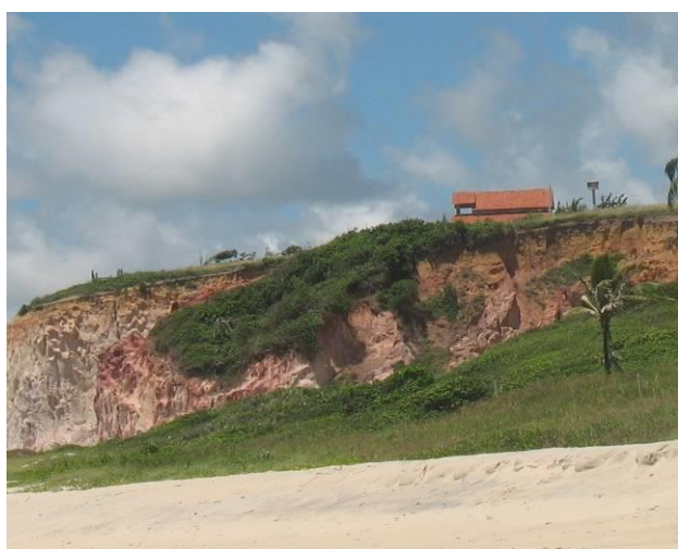
Figura 21. Casa construída na APP das falésias de Praia Bela.
