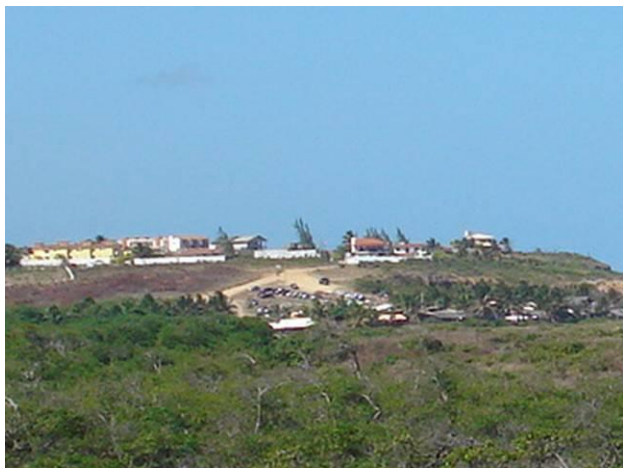
Figura 20. Edificações próximas à borda das falésias de Praia Bela.
