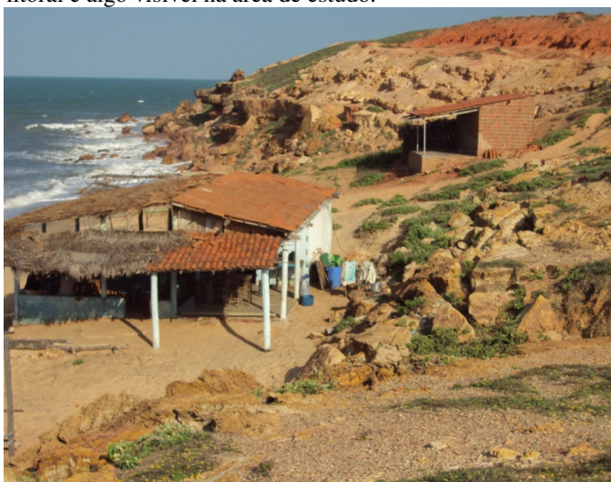
Figura 15 – Despejo de efluentes domésticos sem prévio tratamento na Praia de São Cristovão, Areia Branca - RN, 2010. Fonte: Marcos Henrique de Souza Aurélio
