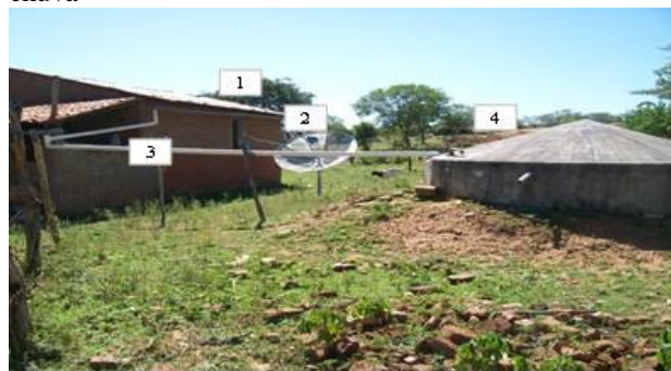
Figura 8. Sistemas de captação e armazenamento de água de chuva
