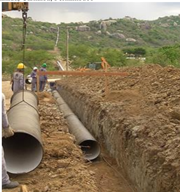
Figura 2. Trecho da construção da adutora do Pajeú, enterrando os dutos de ferro fundido dúctil, sentido Serra Talhada, Carnaíba, Pernambuco
