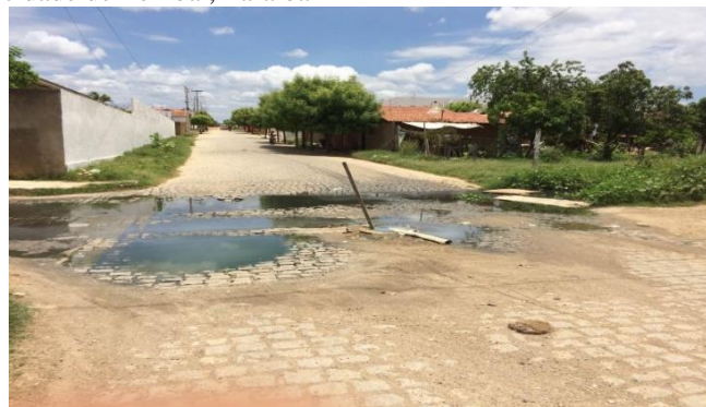
Figura 3. Esgoto lançado a céu aberto no Santo Amaro na cidade de Pombal, Paraíba
