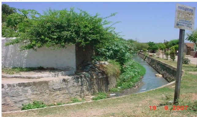
Figura 5. Esgotos lançados na galeria da cidade de Pombal, Paraíba
