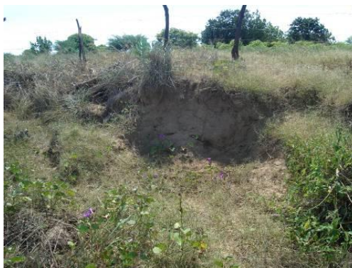
Foto 1: SSD 1 (Subsolo degradado 1)
