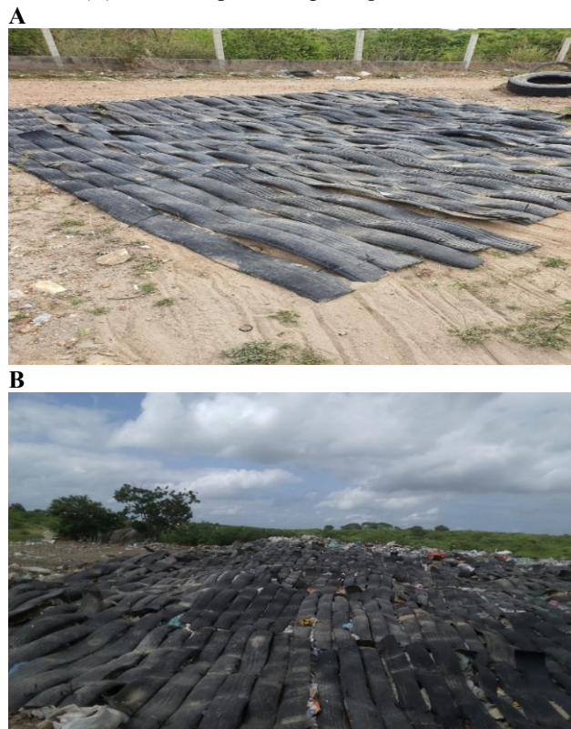
Figura 4. Tapetes de pneus inservíveis (A) em célula de aterro sanitário (B) no município de Itaporanga, Paraíba
