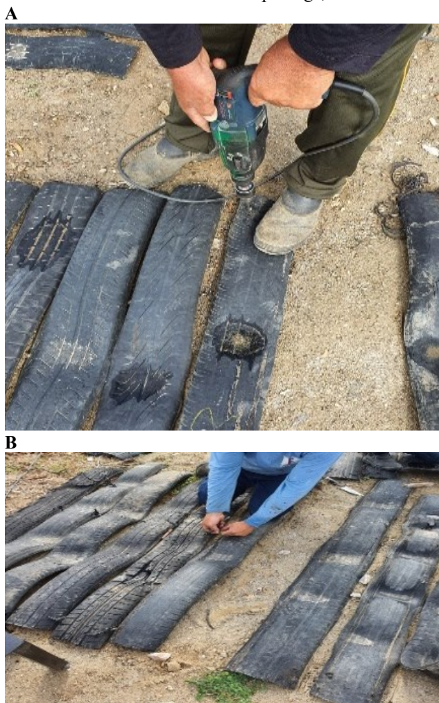
Figura 3. Perfuração (A) e amarração (B) dos tapetes de pneus inservíveis em aterro sanitário de Itaporanga, Paraíba.
